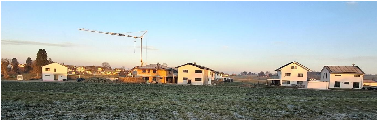
Abbildung 9: Bauweise Lohbühl I aus Richtung Südosten
