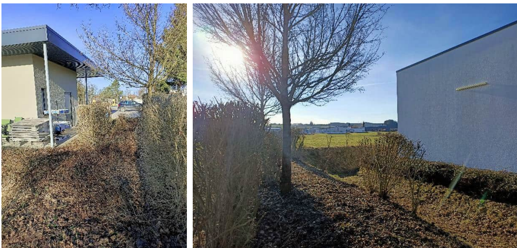
Abbildung 4: Blick auf die Nordostseite des Gebäudes, mit angrenzendem Zwergmispelbewuchs, Ligustersträuchern und Ahornbäumen. Links: Blick Richtung Nordwesten. Rechts: Blick Richtung Südosten.
