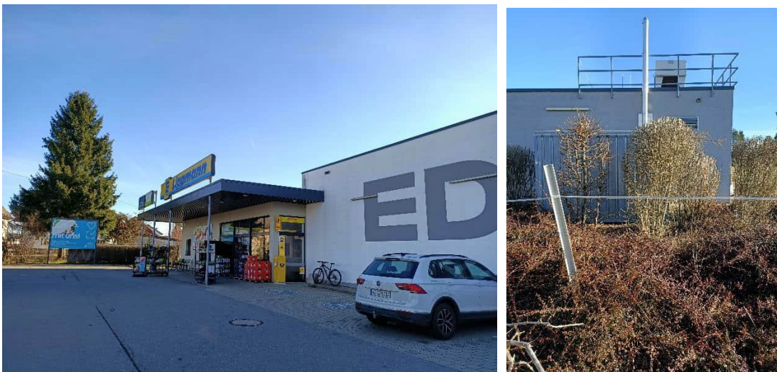
Abbildung 6: Abgeschlossene Bauweise des Gebäudes ohne Spalten, Fassaden und Dachöffnungen
