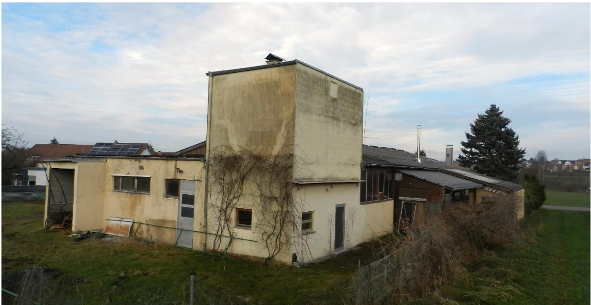
Abbildung 10: Blick von Südosten auf Leerstehendes Gebäude
